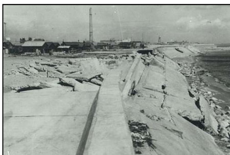
昭和34年9月洪水 高潮堤防被災 (鈴鹿川河口部)
