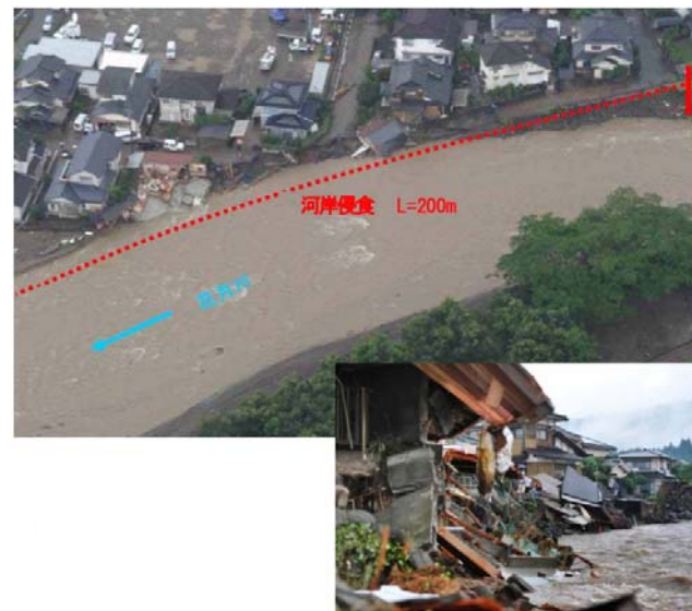
河岸侵食により家屋倒壊した状況
