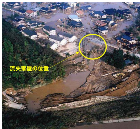
堤防決壊に伴う氾濫流により木造家屋が倒壊した状況
