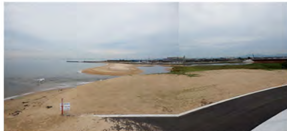
鈴鹿川派川河口部の状況
