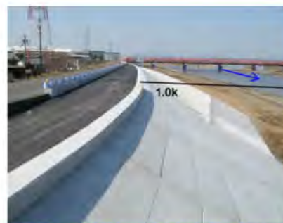
高潮堤整備状況(鈴鹿川右岸1.0k付近)
