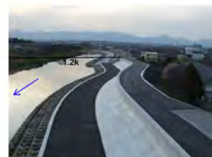
高潮堤整備状況(派川左岸1.2k付近)
