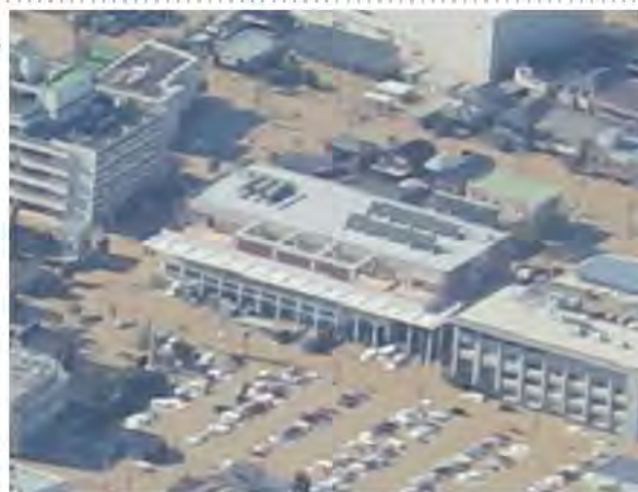
常総市役所の浸水の状況
