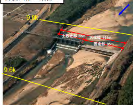
鈴鹿川第二頭首工
