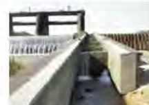
鈴鹿川第二頭首工魚道
