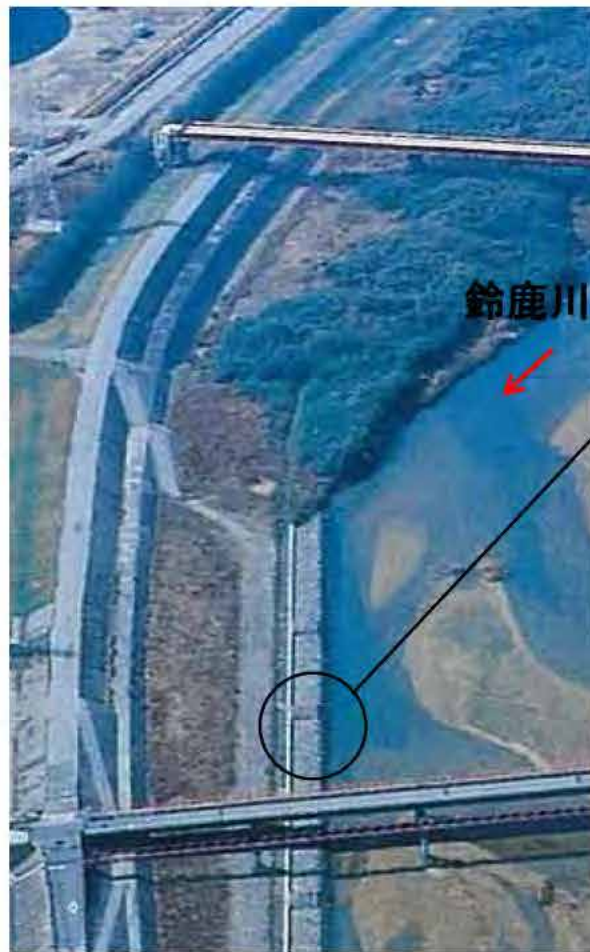
洗掘の状況 [鈴鹿川右岸1.4k付近低水部]
