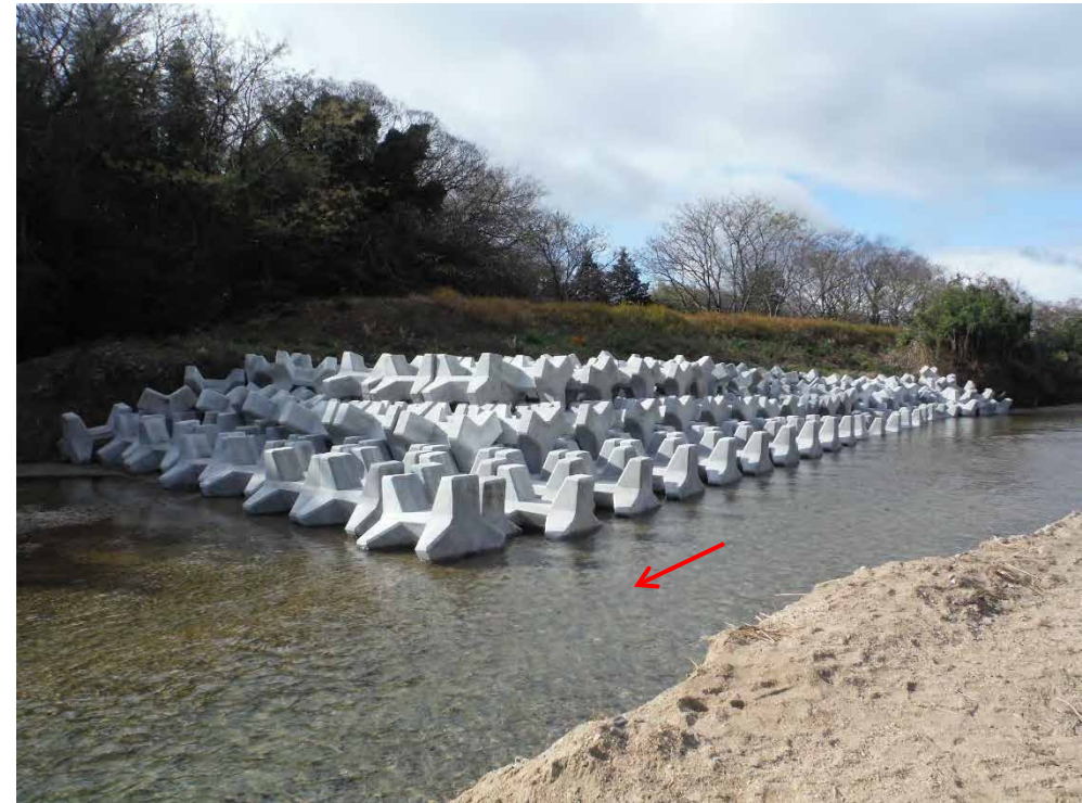
根固め工(安楽川右岸0.9k付近)
