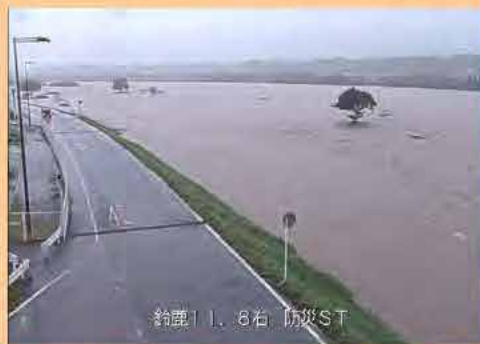
CCTVカメラによる映像
