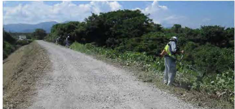
堤防除草の作業状況
