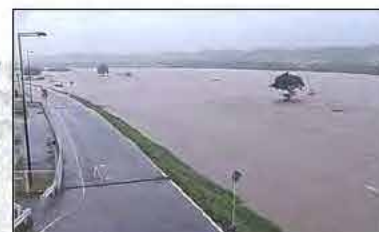
CCTVカメラ (鈴鹿川右岸11.8k付近)
