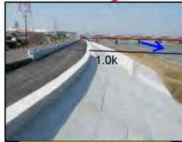
(鈴鹿川右岸1.0k付近)
