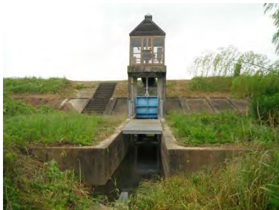
和泉第一排水ひ管 (鈴鹿川 左岸15.4k付近)
