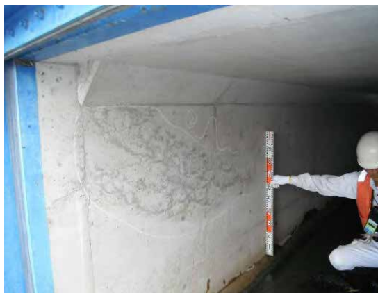
和泉第一樋管 (点検写真)
