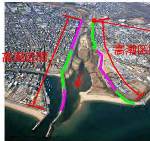
高潮区間と高潮堤防整備状況 (派川)
