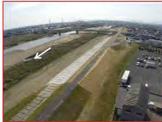
堤防整備(鈴鹿川左岸2.2k付近)
