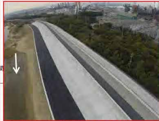
高潮堤防整備(鈴鹿川左岸0.8k付近)
