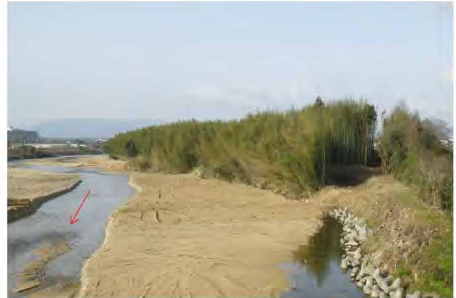
高水敷樹林の侵入 （鈴鹿川左岸16.2k付近）
