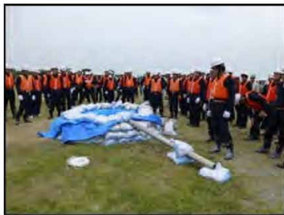
水防活動の実施状況 (月輪工法)
