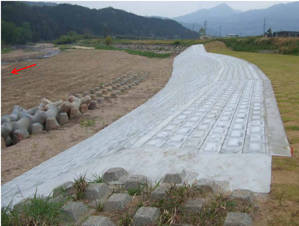
低水護岸(鈴鹿川左岸27.8k付近)
