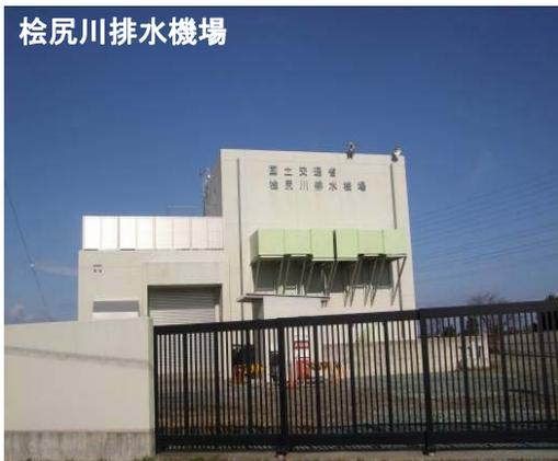
三重県・伊勢市の桧尻川暫定河道改修（1/5確率規模）に対応するポンプがH19年に完成しており、整備計画期間内において、全体計画（1/10確率規模）に対応する河道改修が完了する予定（H40年度完了予定）であることから、1/10対応のポンプ規模19.5m<sup>3</sup>/sまで増強する必要がある。
