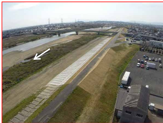
堤防整備(鈴鹿川左岸2.2k付近)
