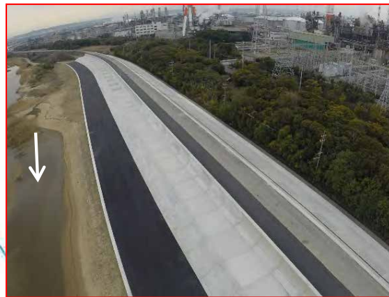
高潮堤防整備(鈴鹿川左岸0.8k付近)
