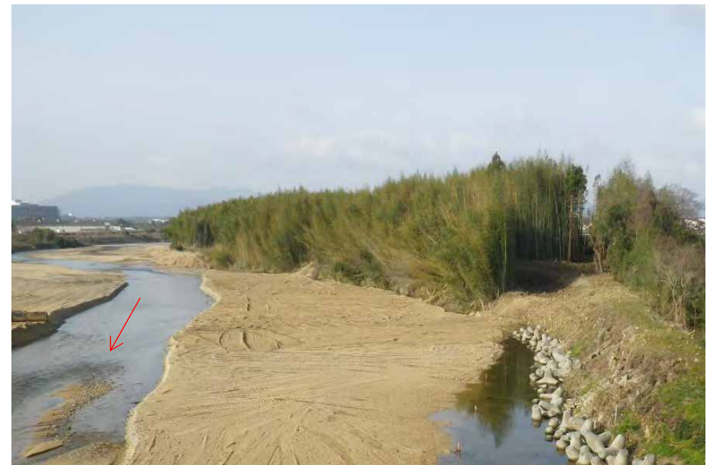
高水敷樹林の侵入 (鈴鹿川左岸16.2k付近)
