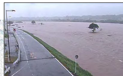
CCTVカメラ (鈴鹿川右岸11.8k付近)
