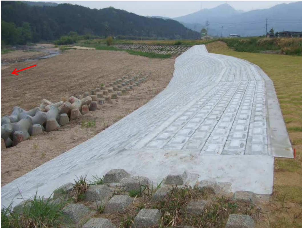
低水護岸(鈴鹿川左岸27.8k付近)
