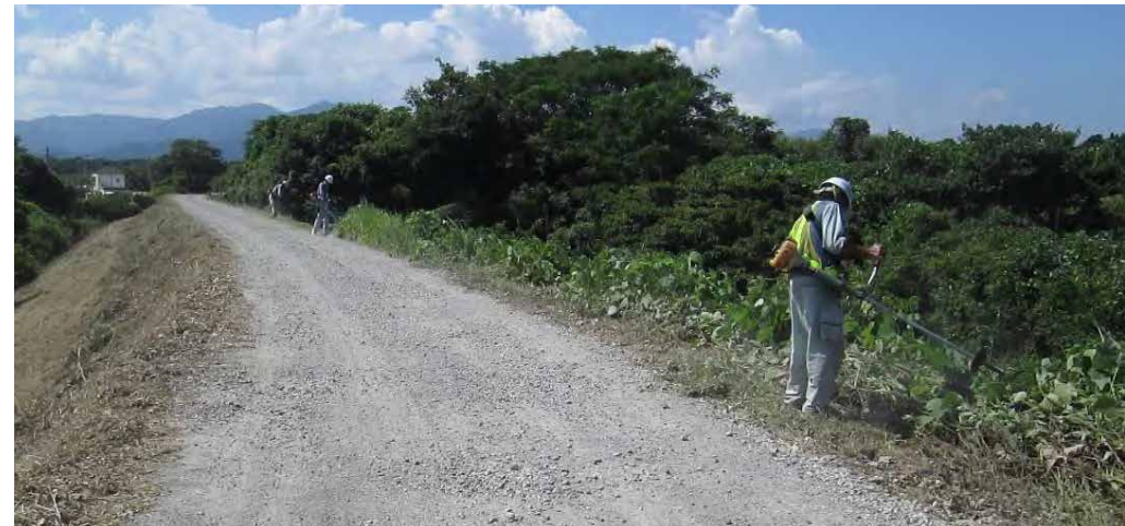
堤防除草の作業状況
