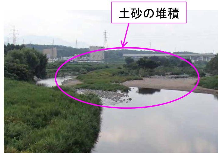
土砂の堆積状況 [鈴鹿川 26.0k付近]
