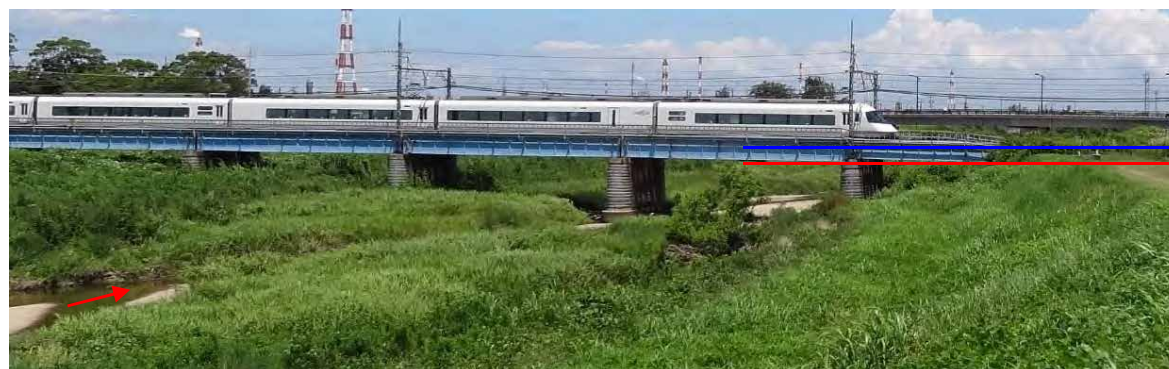
桁下高不足の橋梁 (派川1.8k+83.65：近鉄橋梁)
