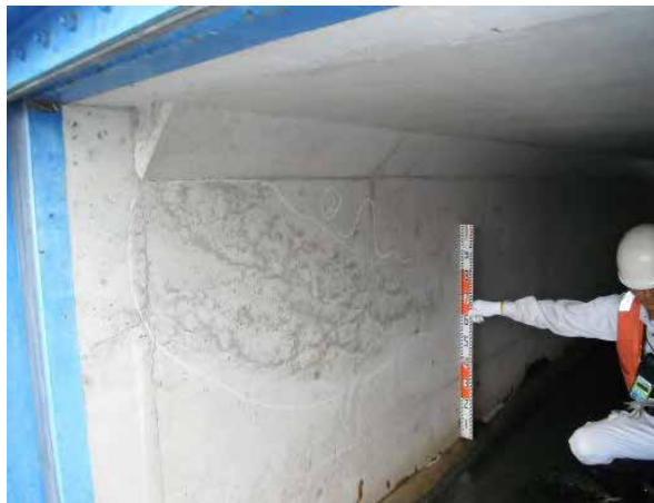
和泉第一樋管 (点検写真)
