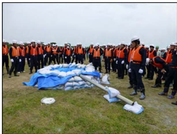
水防活動の実施状況 (月輪工法)
