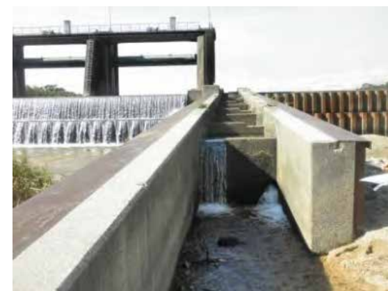
鈴鹿川第二頭首工 (H26. 12撮影)
