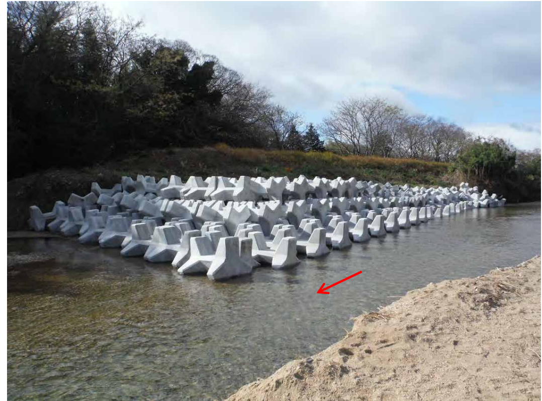
根固め工(安楽川右岸0.9k付近)
