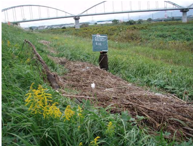
流木（H25年10月、鈴鹿川右岸2.8k付近）
