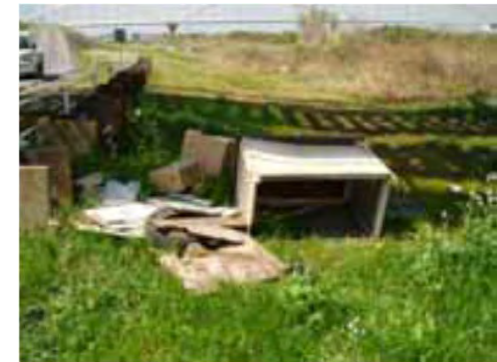
鈴鹿川 右岸2.6k付近
