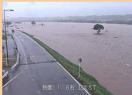
CCTVカメラによる映像
