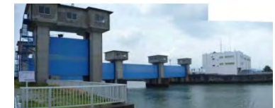
勢田川防潮水門と勢田川排水機場
