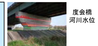
度会橋 河川水位 わかりやすい防災情報の表示
