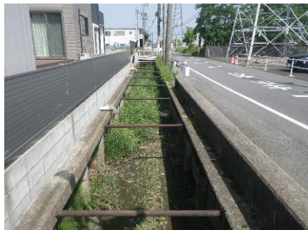
排水路清掃(施工前)
