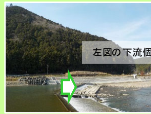
（覆土ブロック整備中）
