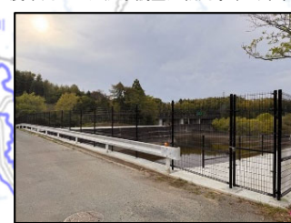
農業用ため池洪水調整池転用事業（津市）
