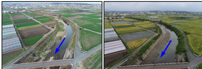
外城田川河道掘削(左:施工前 右:施工後) (三重県)
