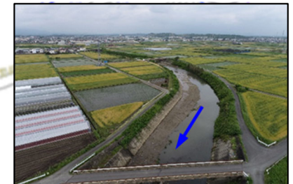
外城田川河道掘削(三重県)
