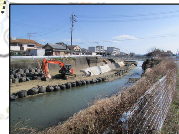
外城田川河道掘削(玉城町)
