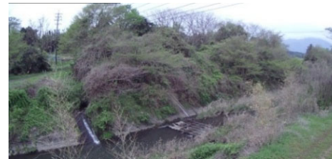
簡易型河川監視カメラからの映像（内部川）
