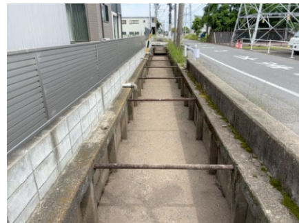
排水路清掃(施工後)
