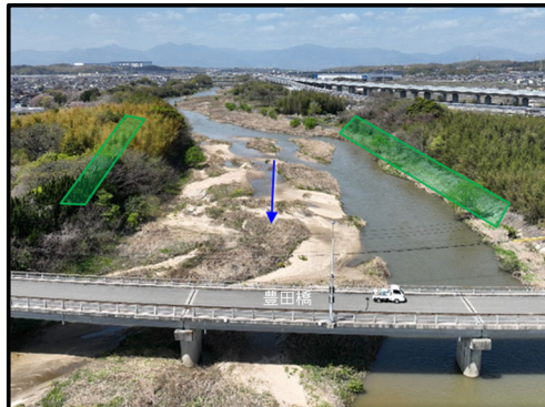
朝明川における護岸整備 （三重県）
