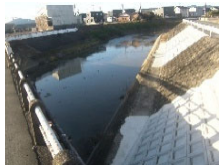
外城田川河道掘削 （玉城町）
