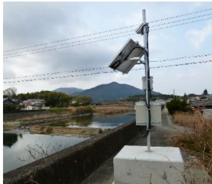
簡易型河川監視カメラ （三重県）
