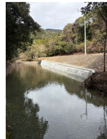
奥川における流木土撤去・災害復旧 （左：施工前 右：施工後）（大紀町）
