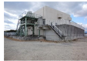
半田川田ポンプ場
