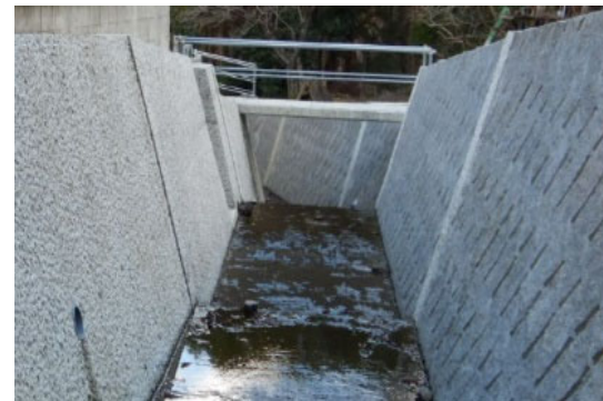
津市内河川における河道拡幅 （津市）
