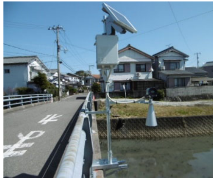
危機管理型水位計 （三重県）
