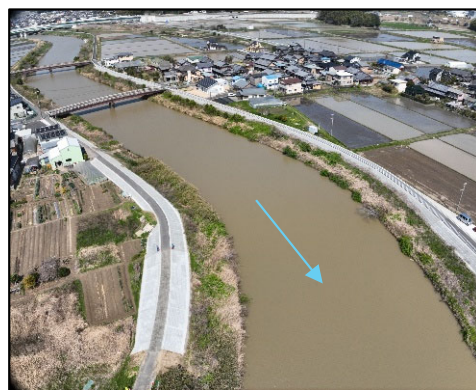
中ノ川における堤防補強 （三重県）
