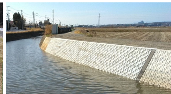
稲生新川における護岸整備 （鈴鹿市）
