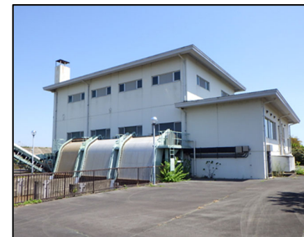
江川排水機場施設の延命化 （三重県）
