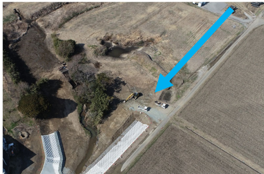
三泗川における護岸整備 （三重県）
