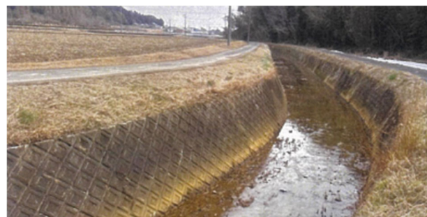
中ノ川水系井出川 における堆積土砂撤去 （鈴鹿市）
