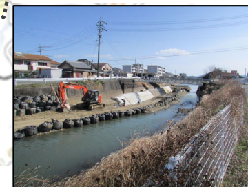
外城田川河道掘削（玉城町）
