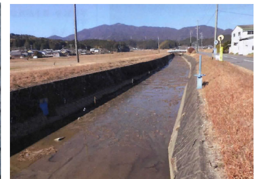
津市内河川における河道掘削 （津市）
