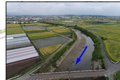
外城田川河道掘削（三重県）
