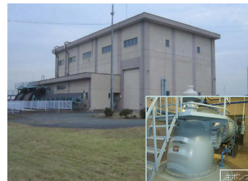
百々川排水機場延命化対策 （三重県）
