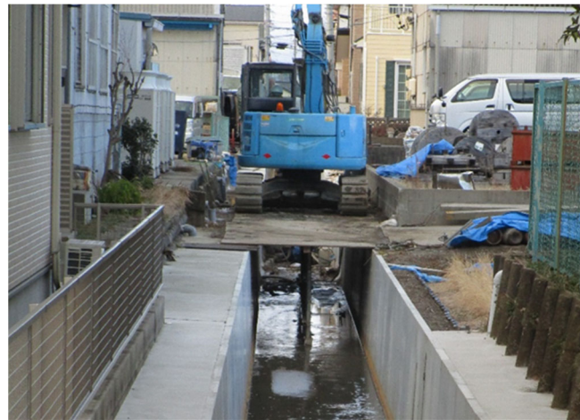
下水道（雨水排水）施設の整備
