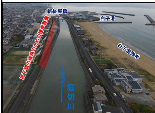
堀切川における護岸整備 （三重県）
