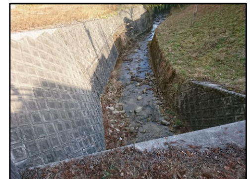
雲田川における浚渫 （菰野町）
