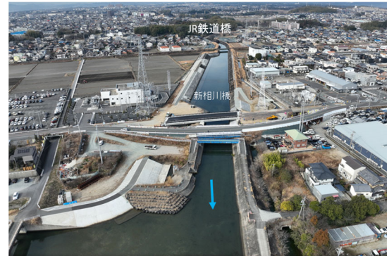
相川における橋梁架替 （三重県）
