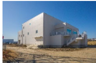
天神ポンプ場
