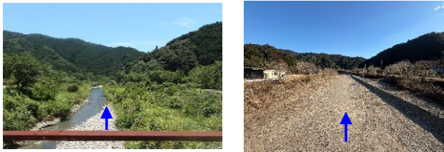
古和川における河道掘削(左:施工前 右:施工後)
