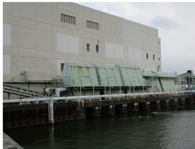
ポンプ場整備
