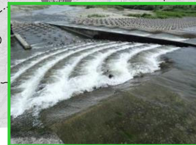
縦断連続性の確保 （三重河川国道事務所）
