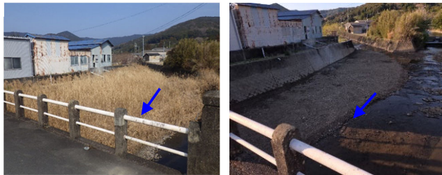
五ヶ所川における河道掘削(左:施工前 右:施工後)
