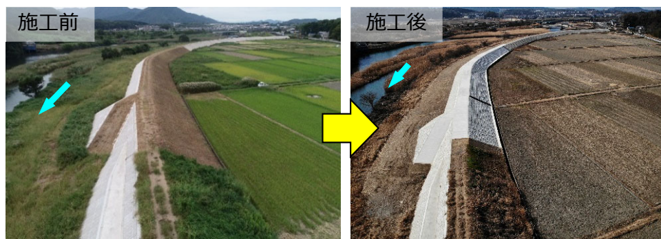
掘割橋上流約800m付近（左岸）
