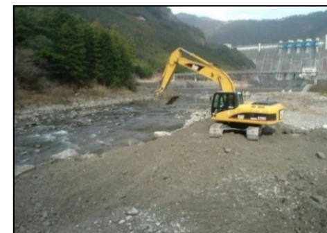
蓮ダム下流置土状況
