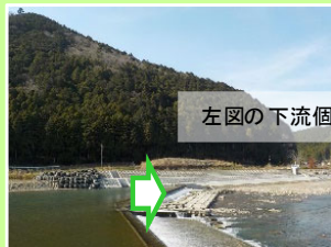
（覆土ブロック整備中）
