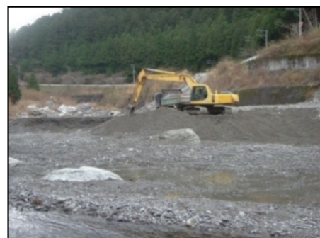
堆積土砂掘削状況
