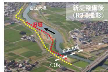
引堤(石川県梯川水系梯川)
