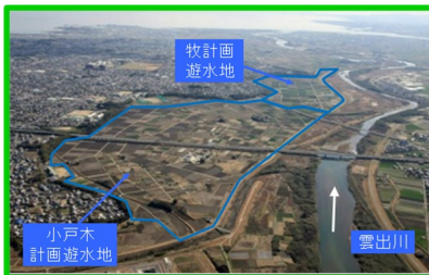
営農機能等を維持した遊水地整備 (三重河川国道事務所)
