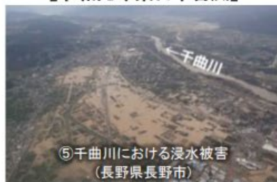
【令和元年東日本台風】
