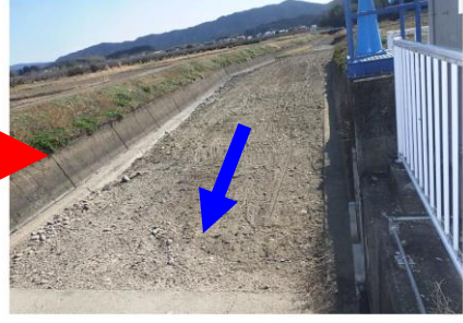
河道掘削後の様子
