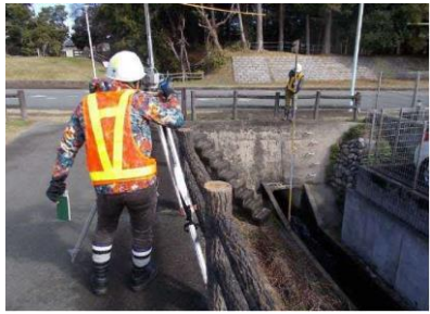
既存水路等の測量調査
