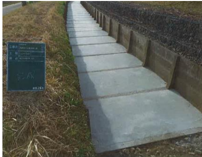
底張りコンクリート
