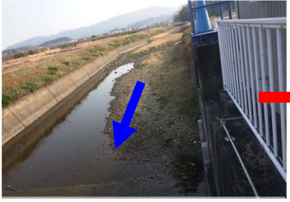
河道掘削前の様子
