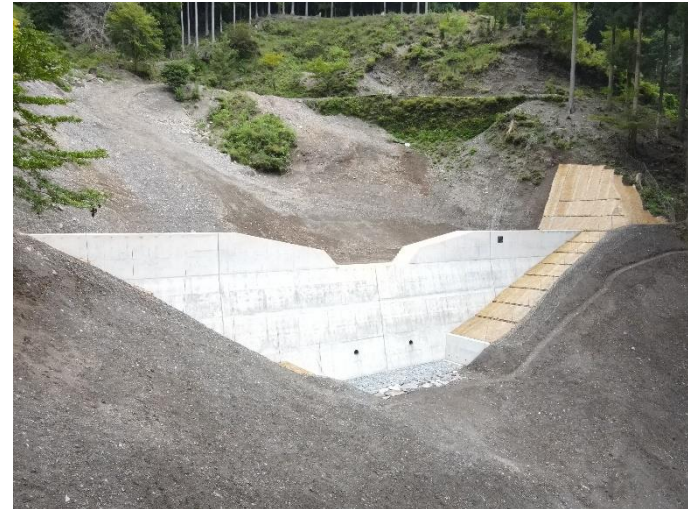
治山ダム整備箇所(松阪市)
