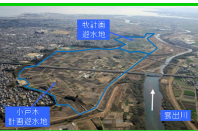
営農機能等を維持した遊水地整備 (三重河川国道事務所)
