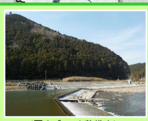
(覆土ブロック整備中)
