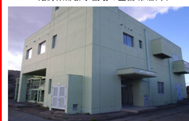
嬉野東部排水機場の整備（松阪市）
