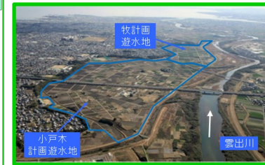
営農機能等を維持した遊水地整備（三重河川国道事務所）
