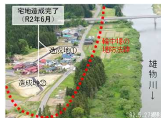
移転先宅地造成完了状況
