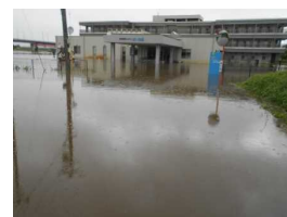
浸水時の状況 (喜多方市提供)
