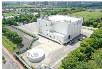
雨水ポンプ場
