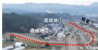
移転家屋の建設が進む状況
