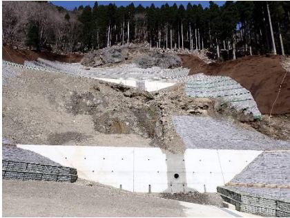
治山工事実施箇所（櫛田川流域）
