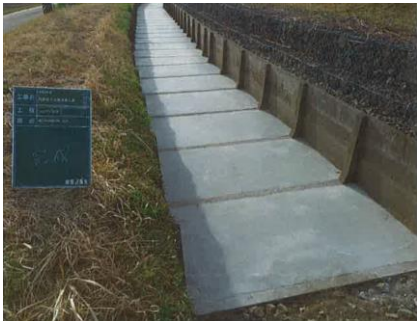
底張コンクリート
