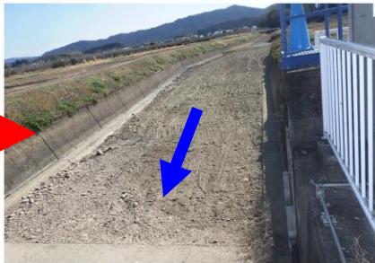
河道掘削後の様子
