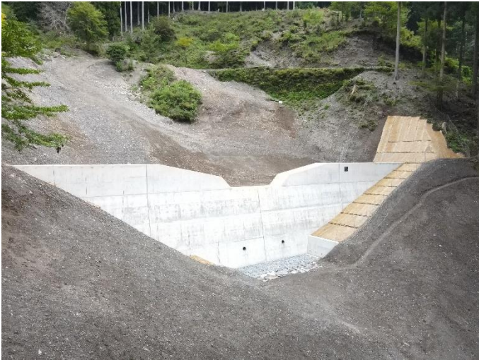
治山ダム整備箇所(松阪市)
