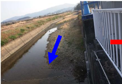
河道掘削前の様子
