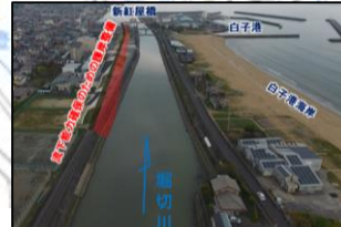
堀切川における河川整備(三重県)
