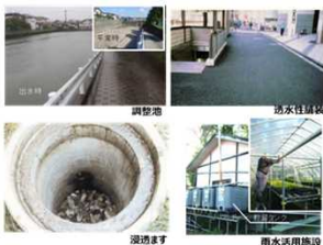
雨水貯留浸透施設の例
