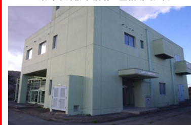
嬉野東部排水機場の整備（松阪市）
