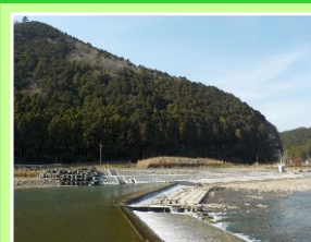
(覆土ブロック整備中)
