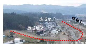
移転家屋の建設が進む状況
