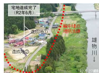
移転先宅地造成完了状況
