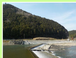
(覆土ブロック整備中)
