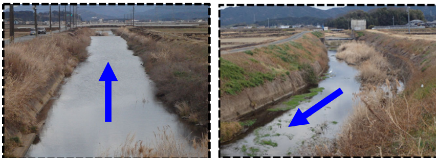
河道掘削、樹木伐採後の様子
