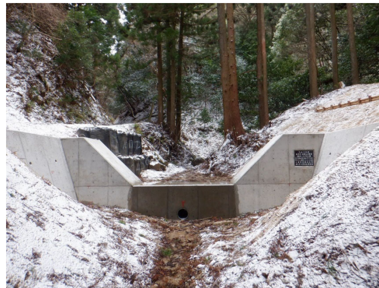
治山ダム整備箇所(亀山市内)
