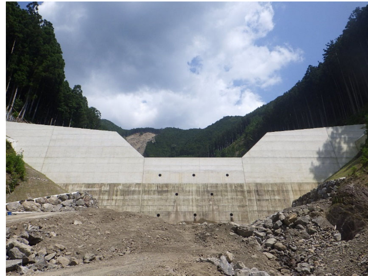
治山ダム整備箇所(大台町内)
