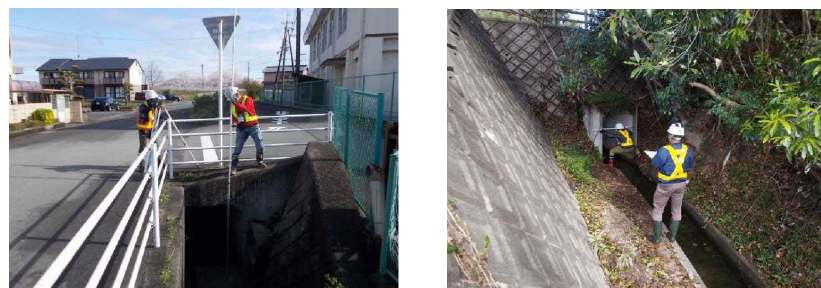
既存水路網の測量調査
