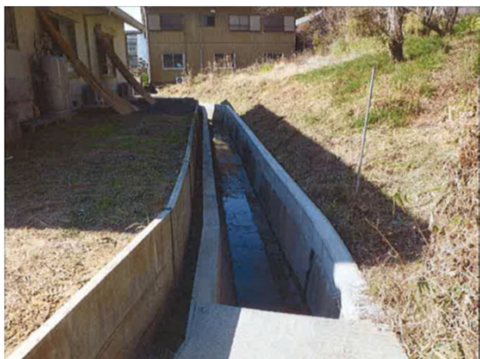
水路壁の嵩上げ
