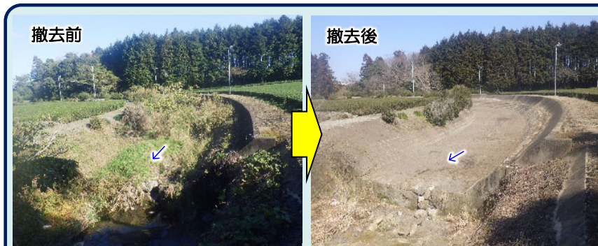
一級河川鎌谷川（四日市市水沢町地内）
