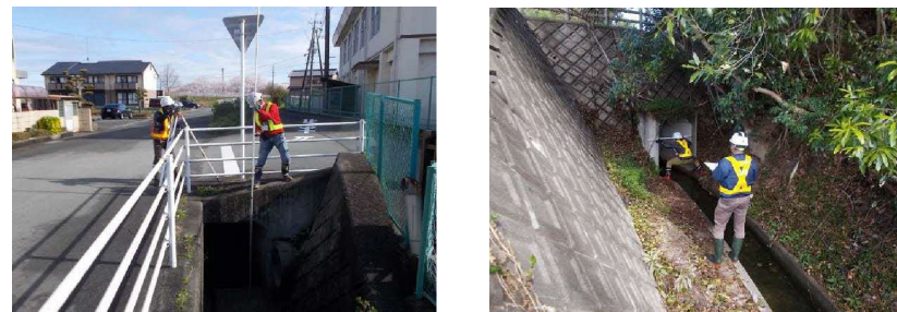
既存水路網の測量調査
