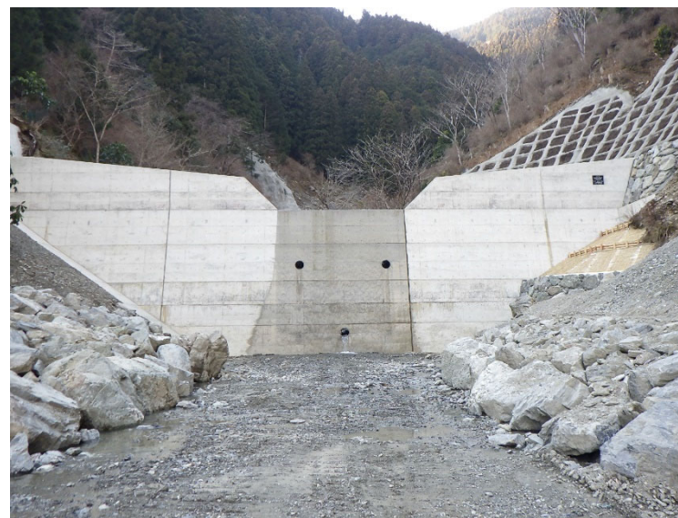
治山ダム整備箇所(松阪市内)
