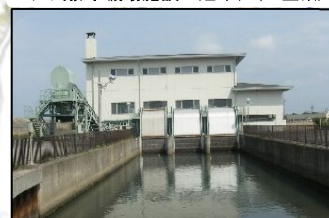
江川排水機場施設の延命化(三重県)
