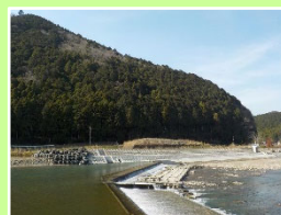
（覆土ブロック整備中）
