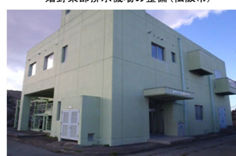
蟬野東部排水機場の整備（松阪市）
