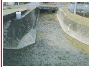
王子討谷川の土砂撤去（津市）
