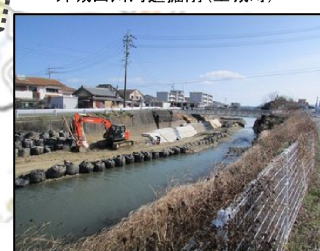
外城田川河道掘削(玉城町)
