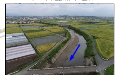
外城田川河道掘削(三重県)
