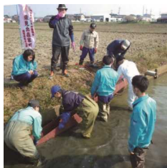
④ 集落総出で魚道を設置
