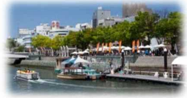
親水護岸の利用 (新町川／徳島市)
