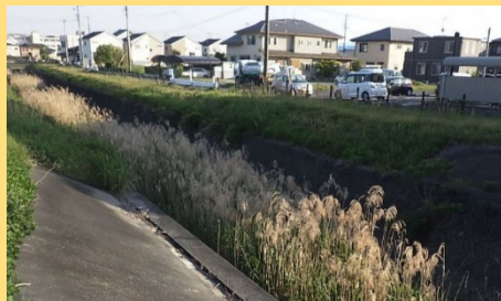
河道掘削(除草)前の状況
