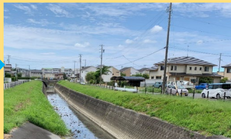
河道掘削(除草)後の状況
