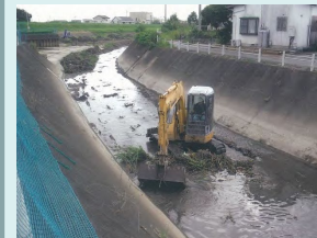
令和2年に河道掘削を実施済み
