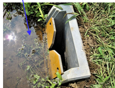
水位調整板の設置イメージ
