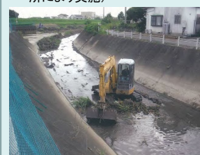
令和2年に河道掘削を実施済み
