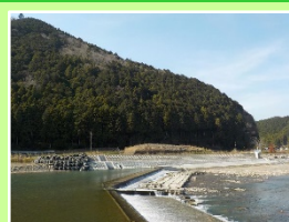
（覆土ブロック整備中）
