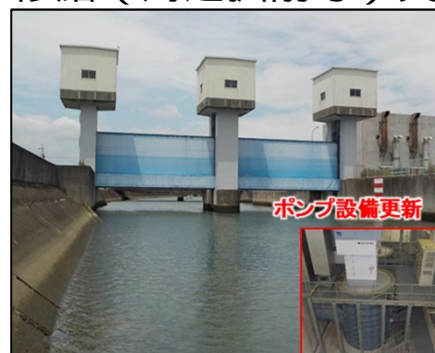
堀切川排水機場延命化対策事業 (ポンプ設備更新)(三重県)
