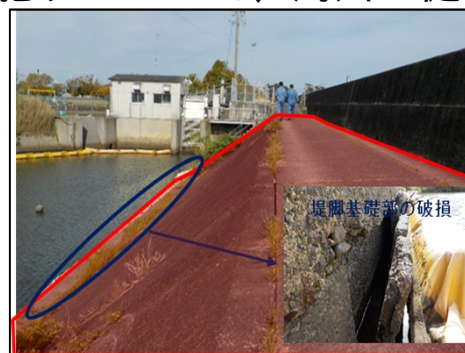
堀切川における堤防補強 (三重県)
