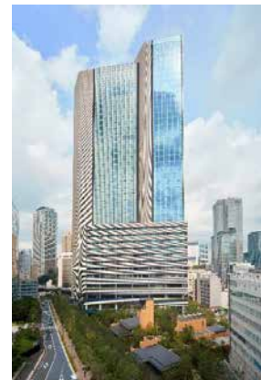
赤坂インターシティAIR 外観
