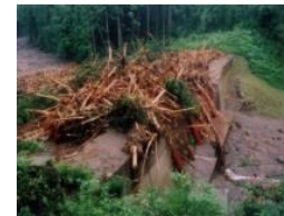
流木捕捉式治山ダム
