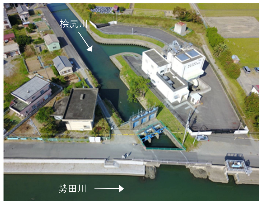
勢田川（伊勢市） 桧尻川排水機場増設
