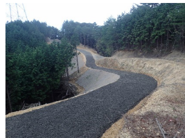
【森林整備：林道（整備）】
