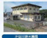
汁谷川排水機場
