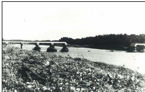
昭和46年8月洪水 橋梁流出 (鈴鹿川23.4k付近:野村橋)
