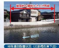
特殊堤防設置状況(北新橋右岸下流)
