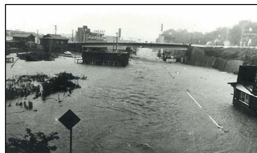
昭和49年7月洪水 浸水状況 (亀山市駅前)
