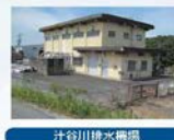
汁谷川排水機場
