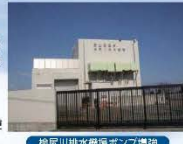
桧尻川排水機場ポンプ増強
