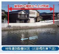
特殊堤防設置状況(北新橋右岸下流)
