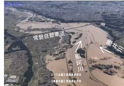
写真① 浸水被害状況（茨城県水戸市）
