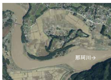
写真④ 浸水被害状況（那珂川左岸61.0k）
