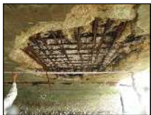
内部の鉄筋が露出した橋梁
