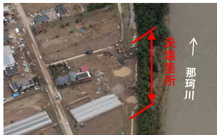
写真③ 堤防決壊状況（那珂川左岸40.0km）
