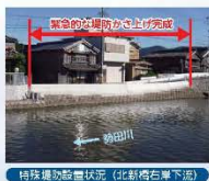
特殊運動防護状況(北新橋右岸下流)
