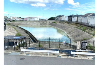
※調整池の施工例イメージ（四日市市雨水管理総合計画より）
