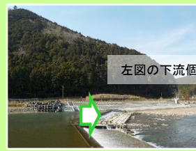
（覆土ブロック整備中）
