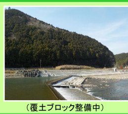
(覆土ブロック整備中)
