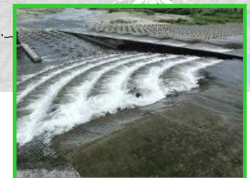
縦断連続性の確保 （三重河川国道事務所）
