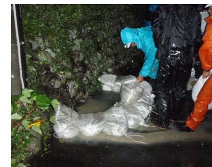
漏水の発生 (H16年9月洪水)
