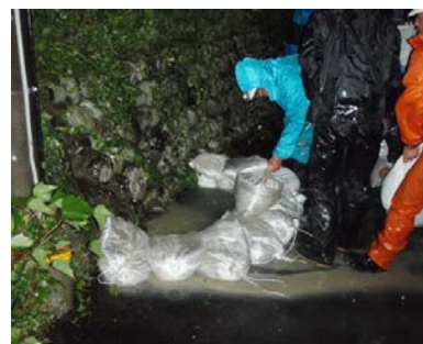
漏水の発生 (H16年9月洪水)
