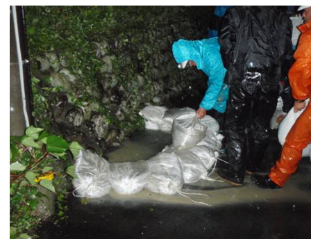
漏水の発生（H16年9月洪水）
