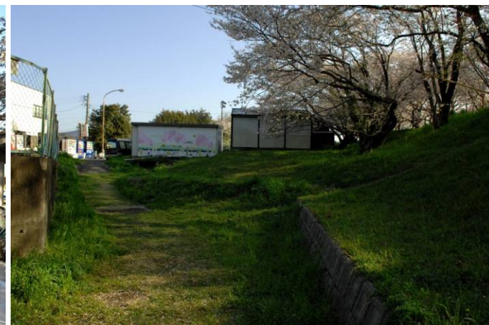
通路より低い位置にある水防倉庫
