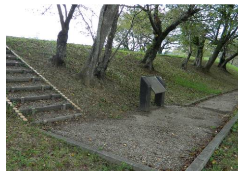
棒堤下流 桜の渡し (宮川右岸6.5k付近)
