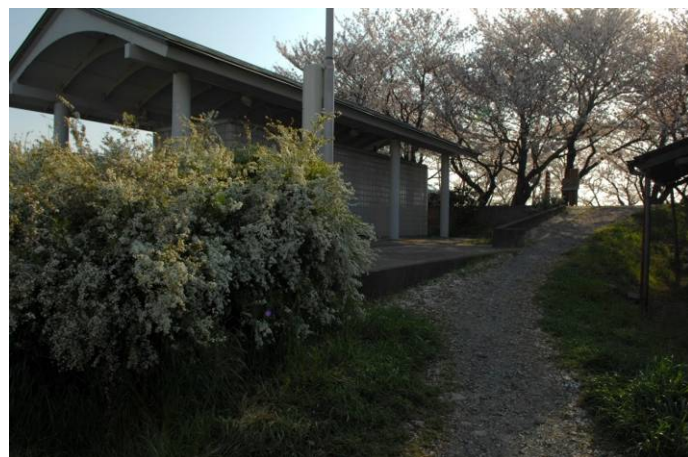
通路より低い位置に公衆トイレ
