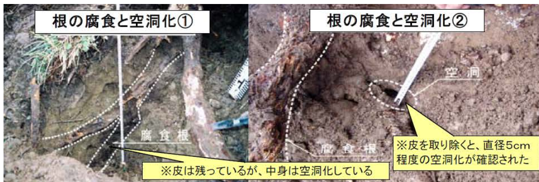
雄物川における調査事例（湯沢河川国道事務所）
