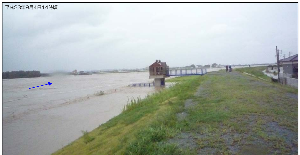
堤防整備箇所の出水時の状況 (宮川右岸：伊勢市辻久留地区)
