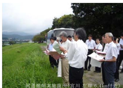
河道掘削実施箇所(宮川 左岸 6.4km付近)
