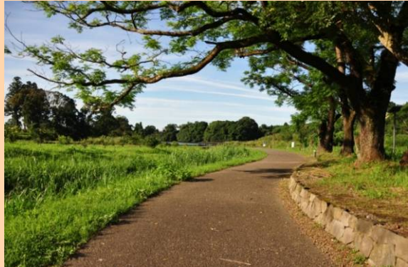
脱色アスファルト舗装（宮崎県西都市）
