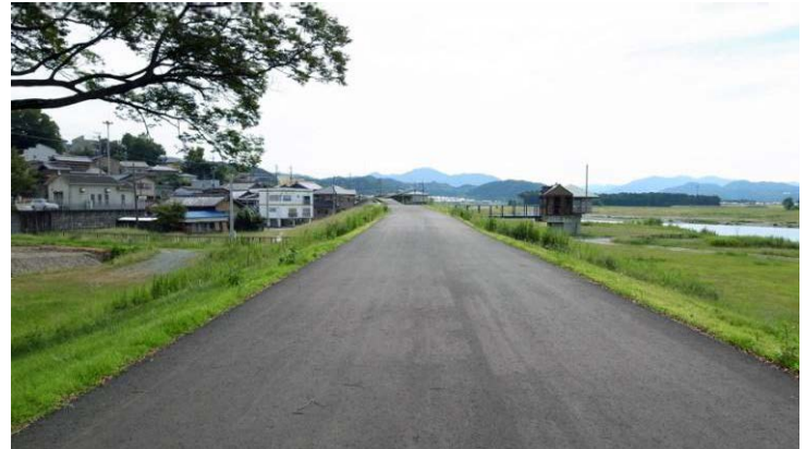
床上対策事業の堤防舗装：天端全体を舗装面（幅6m）とし、開放的な印象。
