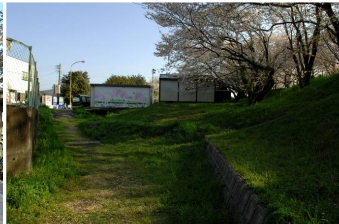
通路より低い位置にある水防倉庫
