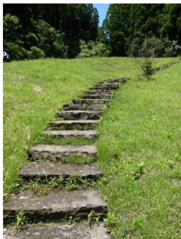
白水ダム駐車場（大分県竹田市）
