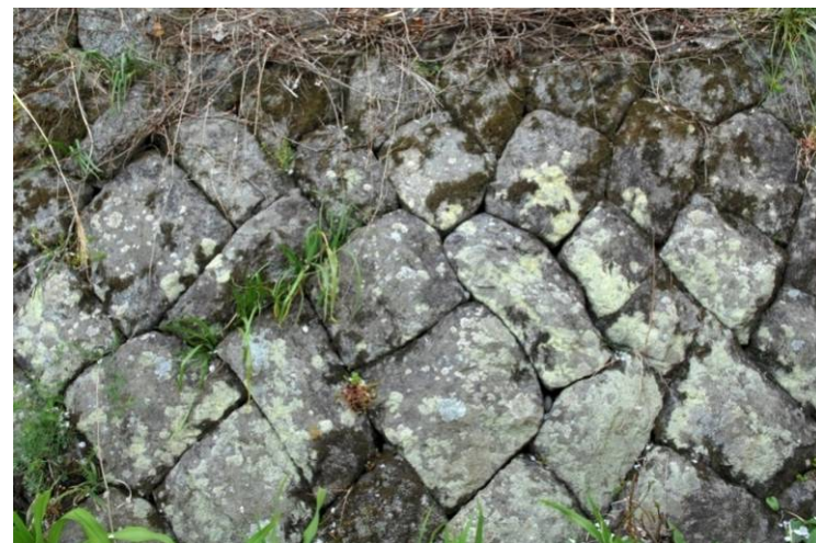
度会橋上流堤防裏に設置されている自然石護岸（空石積み）
