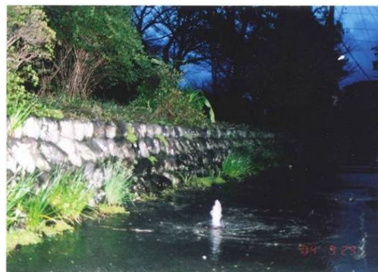
ガマの発生状況 H16年9月出水 右岸7.2km付近
