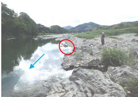
岩盤露出部の河道状況
